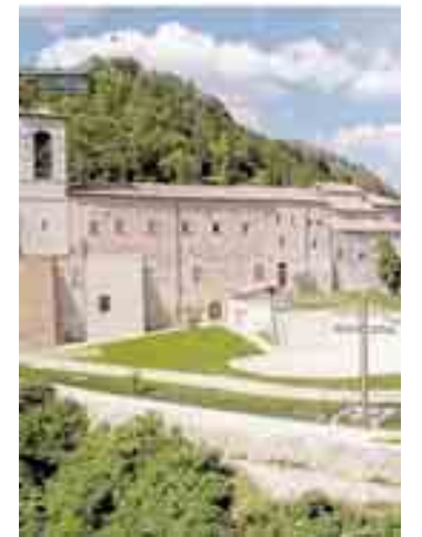
GUBBIO La Basilica di Sant'Ubaldo dopo i lavori
